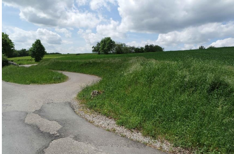
Abbildung 6: Blick auf das im Südosten des Geltungsbereichs angrenzende Rückhaltebecken (Foto © DNP, Mai 2022)
